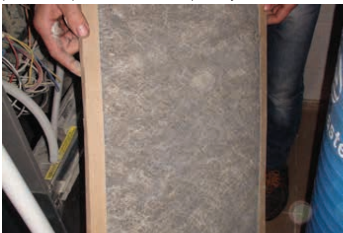
Загрязнённый воздушный фильтр перед воздухонагревателем
