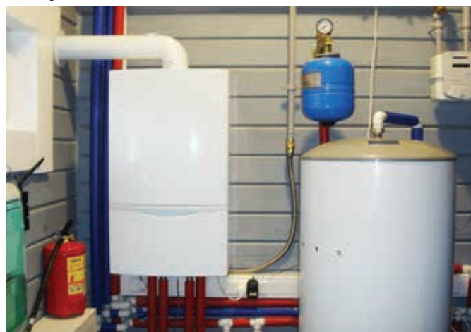
Газовый настенный котёл и бойлер для горячей воды
