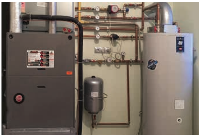
Газовый ёмкостной водонагреватель для ГВС и воздухонагреватель
