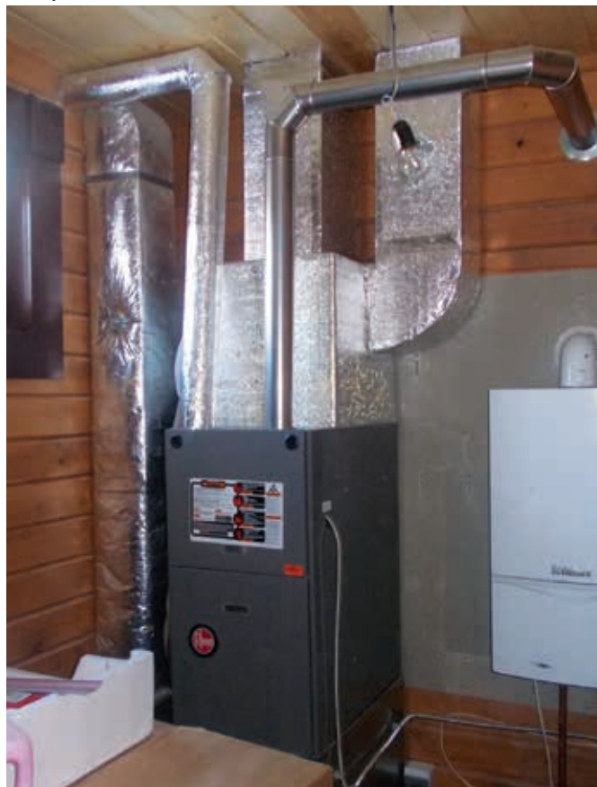
Размещение газового воздухонагревателя в котельной
